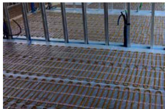
Verlegung des Heizsystems Warmset in der Provinz Vicenza , in Kombination mit einer Ausgleichsmasse.
