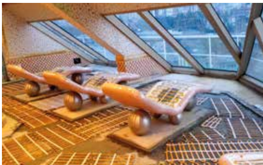
Installation für Kreuzfahrtschiff Costa Fascinosa von Costa Crociere.
