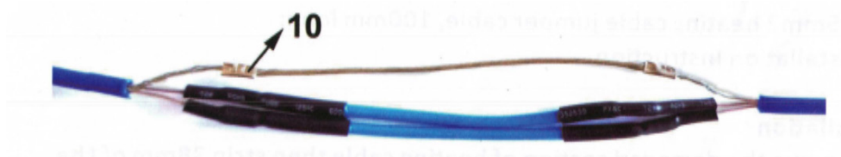
Schritt 10 - Verbindung des Schutzleiter-/Erdungsgeflechtes. Darstellung schematisch.
