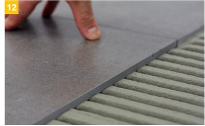
Der Belag wird vollsatt in das Kleberbett gebettet. Insbesondere bei großformatigen Fliesen ist eine Verlegung im kombinierten Verfahren zweckmäßig. Die Klebemörtelstärke sollte 5mm nicht überschreiten.
