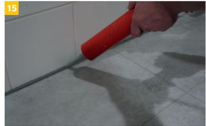
Ausbildung von Anschluss- und Bewegungsfugen mit geeigneten, weichen Fugenfüllstoffen.
