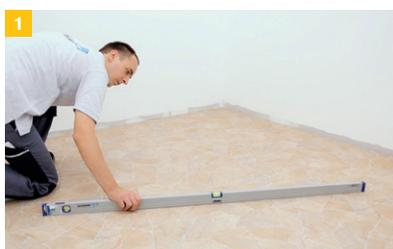
1 Prüfung des Untergrundes auf Eignung und Ebenflächigkeit. Ggfs. sind Ausgleichsarbeiten durchzuführen.
