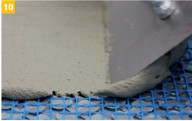
Anschließend wird die IndorTec® FLEXBONE 2E Zug um Zug ausgespachtelt und ...
