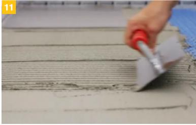
... direkt mit geeigneter Zahnung aufgezahnt. Hinweise zu geeigneten Klebemörteln finden sie auf Seite 2, Punkt 4.
