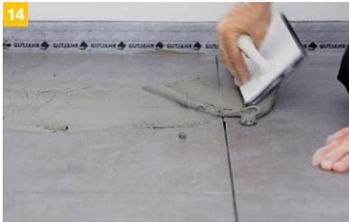
Bitte beachten Sie vor der Verfugung eine längere Durchtrocknungszeit von normal-abbindenden Klebemörteln aufgrund der Nichtsaugfähigkeit des Untergrundes.
