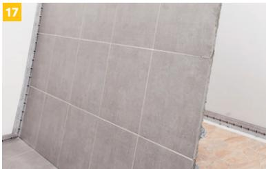
Soll bei Wiederaufnahmebelägen ein partieller Kleberkontakt zum Untergrund vermieden werden, so ist vor der Verlegung eine PE-Folie auszulegen.
