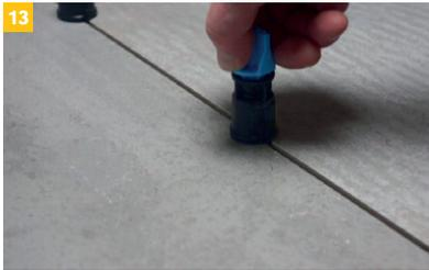
Zur Vermeidung von Überzähnen an der Belagsoberseite können die Nivellierhilfen IndorTec® FN eingesetzt werden.
