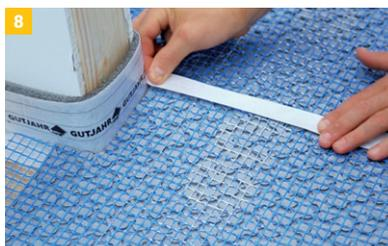
8 ...ist die Fuge, zum Schutz vor Klebemörtleintrag, mit dem Watec® BW Bewegungsfugenband abzukleben. Die Anordnung von Bewegungsfugen im Oberbelag ist deckungsgleich mit der Mattentrennung zu erstellen.
